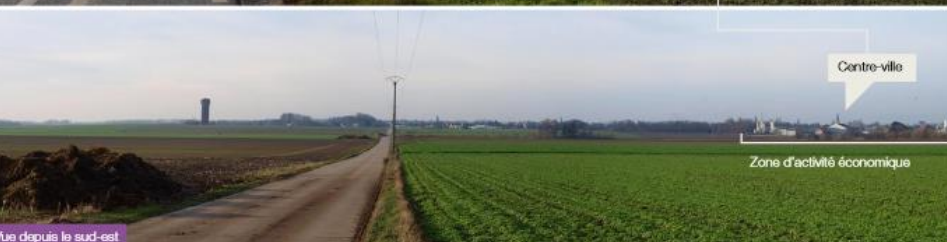
Vue depuis le sud-est
