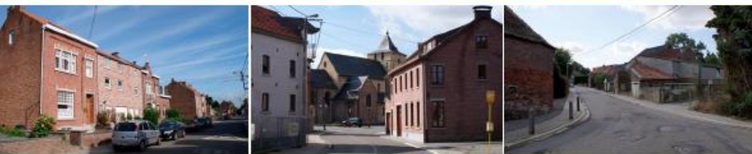
La vallée de la Petite Getta est profondément marquée par une urbanisation mitoyenne discontinue qui s'organise le long d'une voirie principale, parallèle à l'axe de la vallée. Le large fond de celle-ci a néanmoins permis la mise en place d'un réseau viaire relativement complexe.
