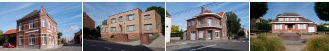
Neerheylissem présente un profil plus urbain que le reste des noyaux villageois de l'aire. On trouve ci et là des habitations dont les styles architecturaux renvoient clairement à différentes époques.
