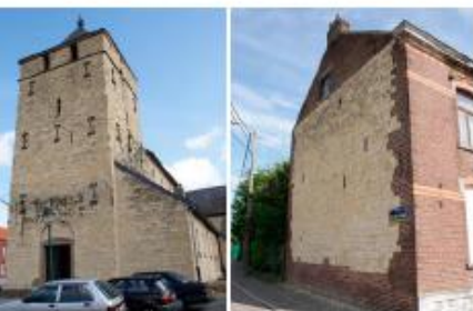
Le tuffeau de Lincourt, de couleur claire, se retrouve dans plusieurs constructions. L'église Saint-Sulpice à Neerheylissem est un bel exemple d'utilisation de ce matériau.
